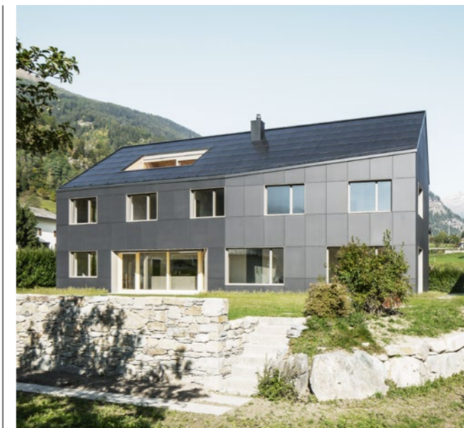
Dieses Plusenergie-Mehrfamilienhaus in Poschiavo (GR) weist einen Solarstromüberschuss von rund 37 000 Kilowattstunden pro Jahr auf.
