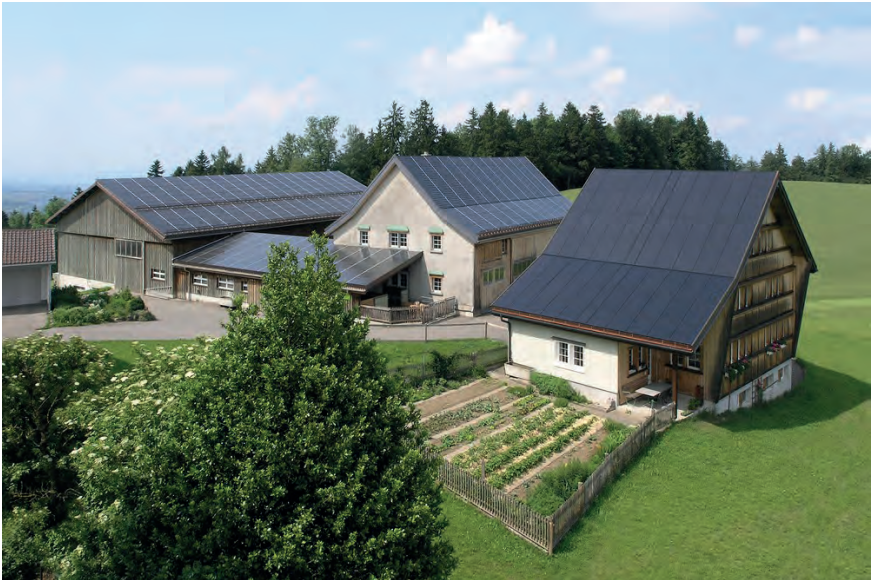
Solaranlagen auf Bauten in der Landwirtschaftszone. Bild: mbr Solar AG
