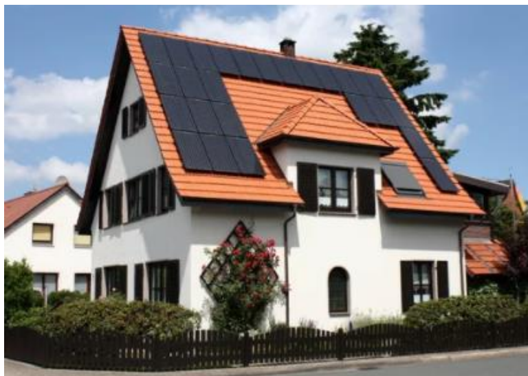
Abbildung 1: Beispiel einer installierten PV-Anlage auf einem Einfamilienhaus mit ca. 10 kWp.
