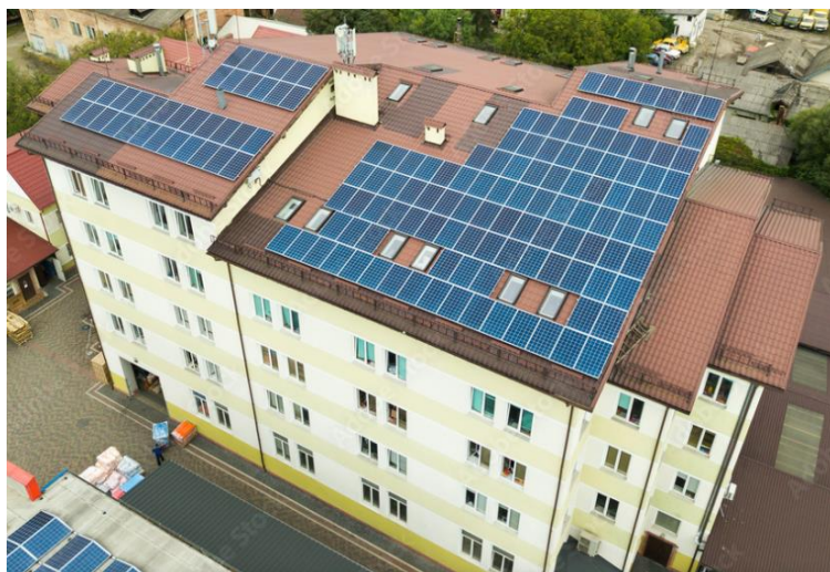
Abbildung 2: Abbildung einer installierten PV-Anlage auf einem Mehrfamilienhaus mit ca. 40 kWp.
