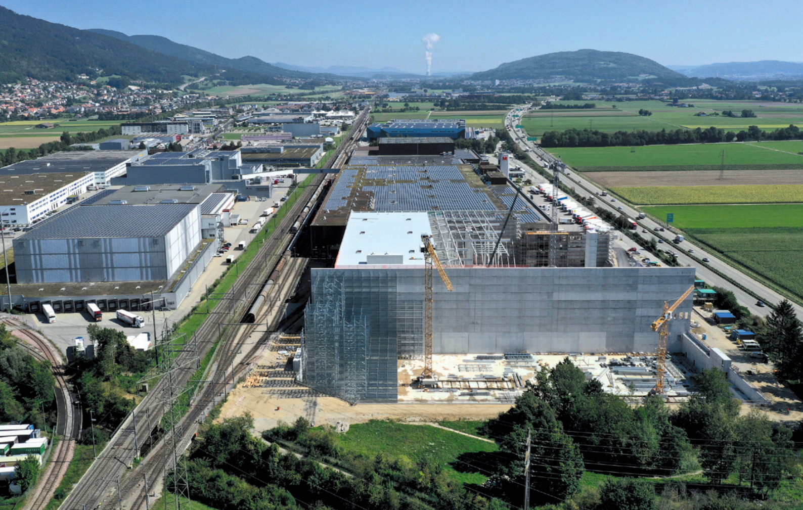
Auf dem Dach des Verteilbetriebs des Lebensmittelproduzenten Migros steht die grösste Solaranlage der Schweiz. Installateur: TRITEC AG
